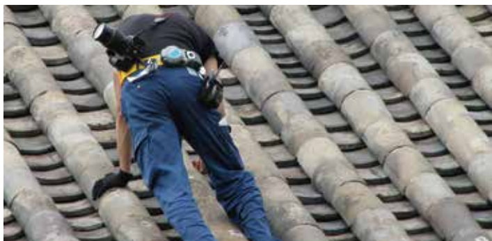
屋根に上がらないので屋根を傷めません
